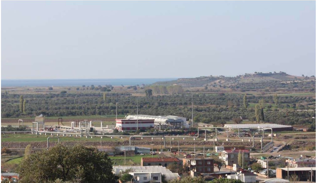
Görsel 4.1.13 Jeotermal Elektrik Santrali Ayvacık/Tuzla
